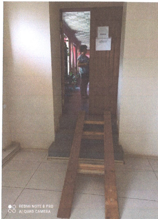
№4. Пути движения внутри здания (к санитарно-бытовому помещению, туалетной комнате)
